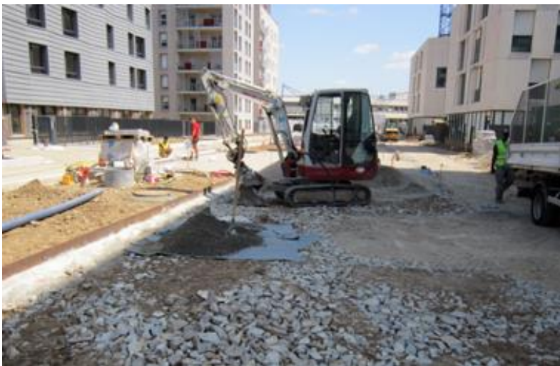
Stockholm : structure de sol à triple objectif : eau/voirie/arbre
