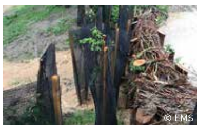
Fonctionnement d'une fascine vivante - Mittelhausbergen
